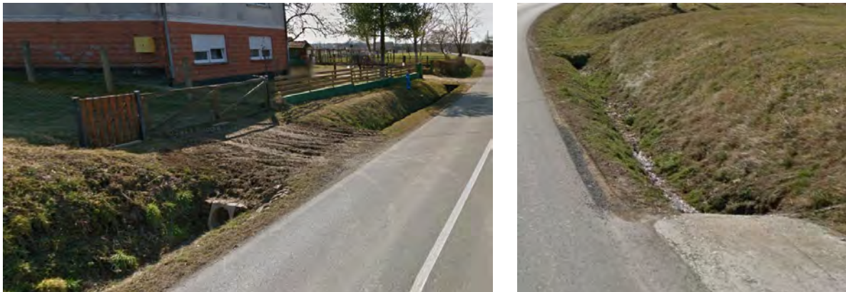
Slika 2.1-1. Način odvodnje oborinskih voda (sustav otvorenih kanala)
