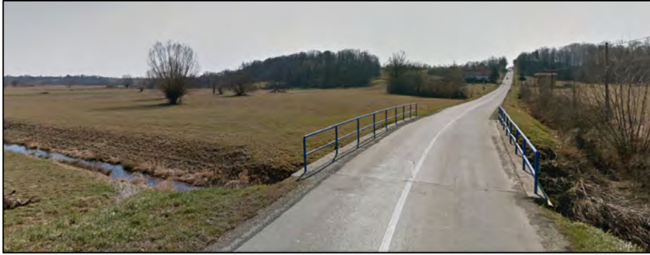
Slika 4.1-1. Postojeći most preko vodotoka Švastica u okviru čije nosive konstrukcije će se postaviti kolektor sustava odvodnje
